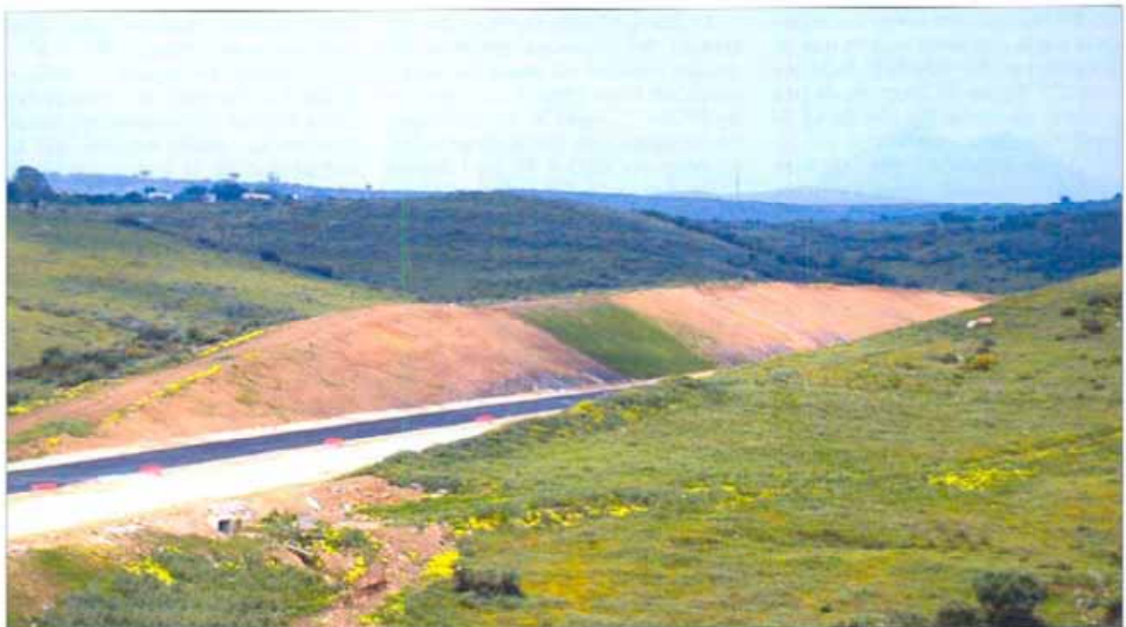
Foto 2.- Los afloramientos rocosos, las fuertes pendientes y la formación de cárcavas son limitantes para la restauración de la cubierta vegetal en desmontes
