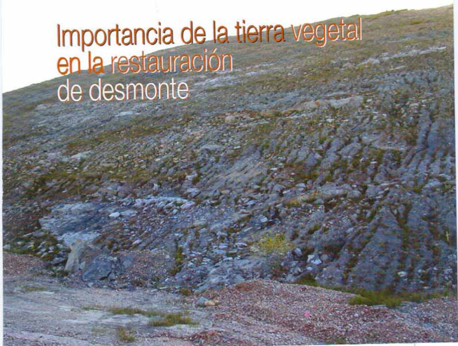
Foto 1.- Desmorte de la Autopista de la Costa del Sol donde se puede observar la franja con tierra vegetal añadida
